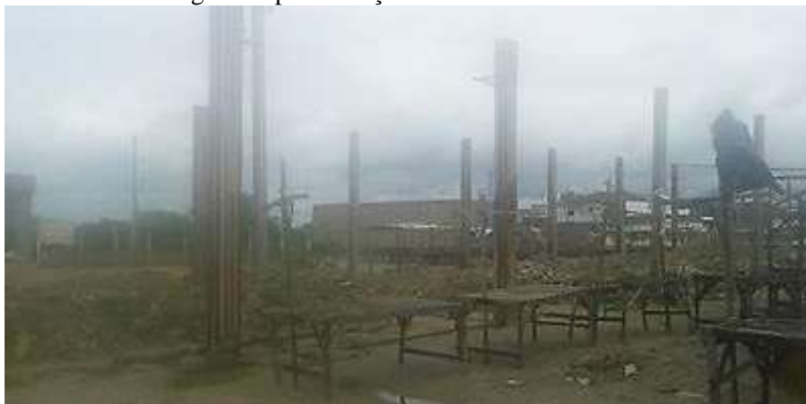
Fig.04: Implementação de uma nova estrutura
